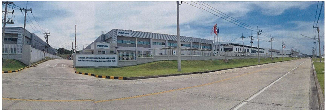
สภาพทั่วไปอาคาร
